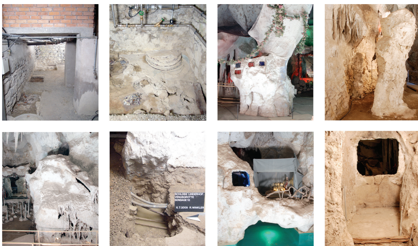
oben links: Beleuchtungsstelle hinter der Glaswand am See, Übersicht und Detail mit eingeputzten Glasstützen. oben Mitte: Beleuchtungsstelle auf der Felsensäule oben rechts: Beleuchtungsstelle auf dem Königssitz, Ausschnitt unten links: Beleuchtungsstelle auf dem Ofen beim Königssitz: Sondage mit Wasserzuleitungen unten rechts: Beleuchtungsstelle auf dem Loreleyfelsen, Übersicht und Detail
